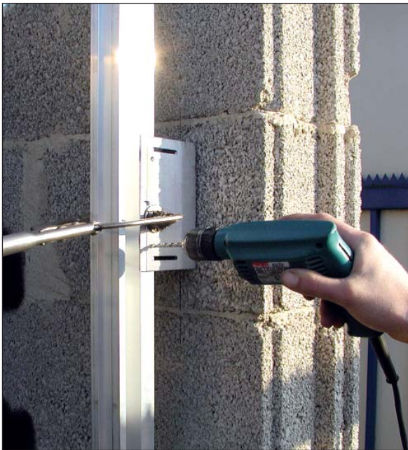
Bohrdurchmesser 5,2 mm
