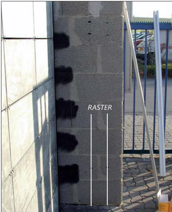
Raster: 310 mm bei Fugenbreite 10 mm.
