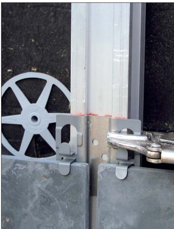
Symmetrische Deckung 600 x 300 mm, vertikal verlegt, auf Alu-UK sichtbar geklammert mit Edelstahl-Befestigungsklammer HE130
